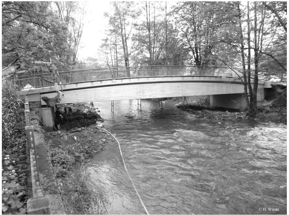
Die sanierte „Fasanenbrücke“
