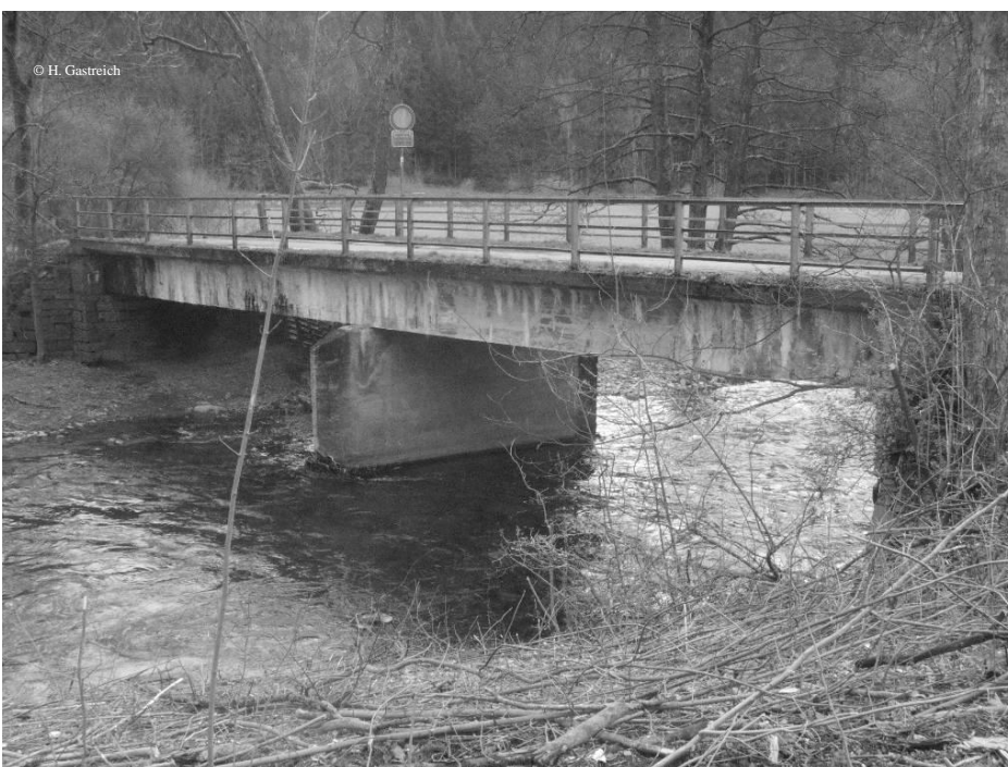
Die Lennebrücke heute
