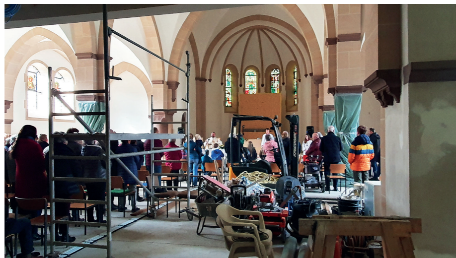
Ostermontag beim Baustellen-Gottesdienst: Auferstehung zwischen Gerüsten
