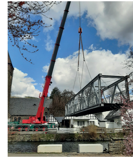
Absetzen auf die vorbereiteten Fundamente
