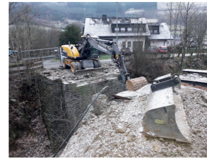
Der Abriss der Bahnbrücke
