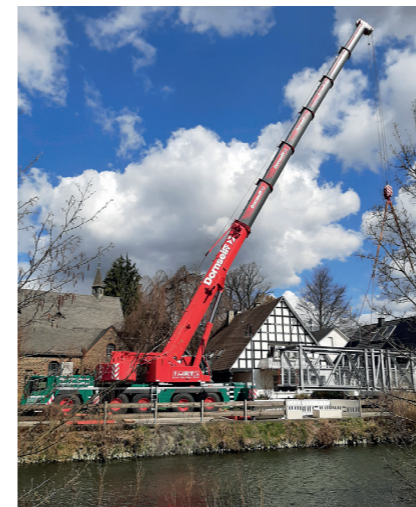
Aufbau der Fußgängerbrücke
