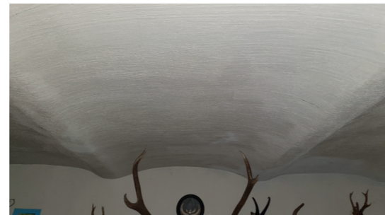
Decke mit Eisenbahnschienen (verputzt)
